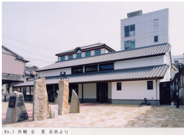
No.1 外観 全 景 北西より
