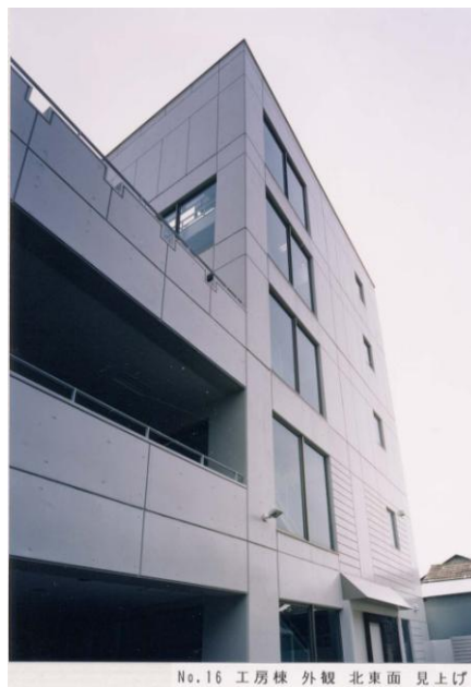
No.16 工房棟 外観 北東面 見上げ
