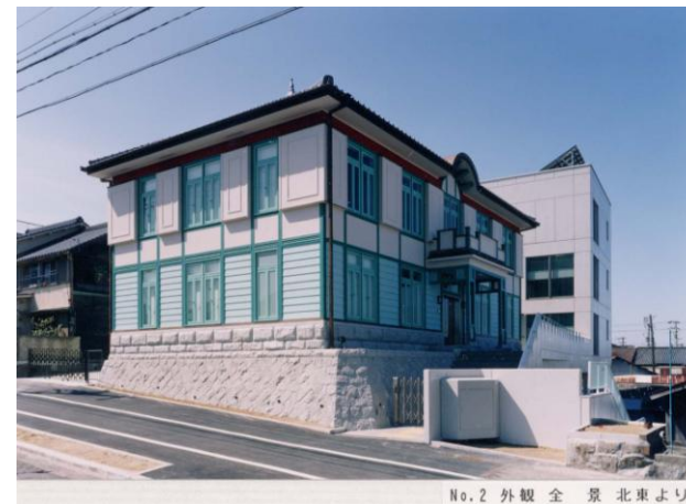
No.2 外観 全 景 北東より
